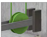
Dispositif tendeur du limiteur de vitesse
