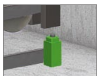
Schalter für Schlaffseilüberwachung (Begrenzerseil)
