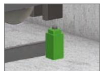
Commutateur de surveillance de câble détendu (câble limiteur)
